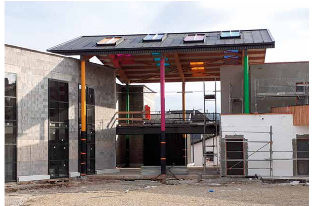
Chantier du nouveau bâtiment de l'IME
