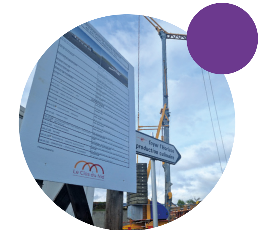
Lancement des travaux de la cuisine de Saint Germain du Teil
